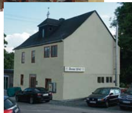
Das alte Schulhaus wurde Gasthaus
